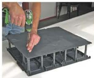
Un bloc coffrage **SolidPool®** se compose de 2 plaques en polypropylène, 20 vis « inserts » et de 2 clips de fixation (haut et bas) : des matériaux d'une grande qualité pour une fiabilité et une durabilité extraordinaire, un assemblage d'une solidité exceptionnelle pour un coulage (béton) sans risque.
