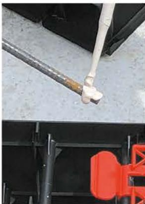
Verser du scellement chimique sur l'extrémité du fer et ensuite l'insérer
