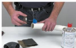
Enduire d'une couche uniforme et régulière, d'abord sur l'entrée de l'emboîture puis sur la totalité du bout mâle, en terminant dans le sens longitudinal.
