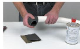
Emboîter à fond jusqu'au repère initialement tracé. Eliminer les excédents de colle, ne pas contraindre à l'assemblage pendant 2 mn pour le rigide et 3h pour le tuyau souple. Mise en pression 24h après.
